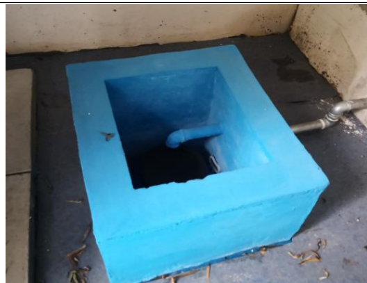
灭菌废气水吸收装置
