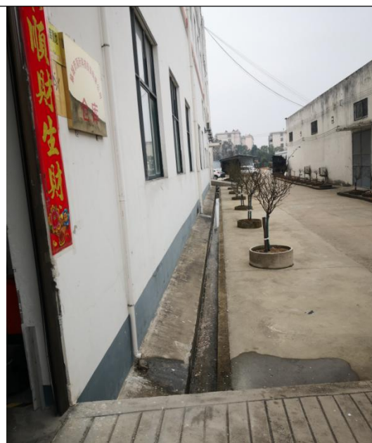
车间雨水排放沟
