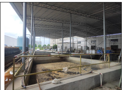
黄冈市润盛祥纺织股份有限公司 污水处理站
